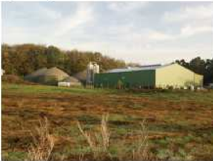
Die Biogasanlage in Rhadereistedt galt bei der Einweihung im Jahr 1999 als Pilotprojekt in ganz Deutschland.
